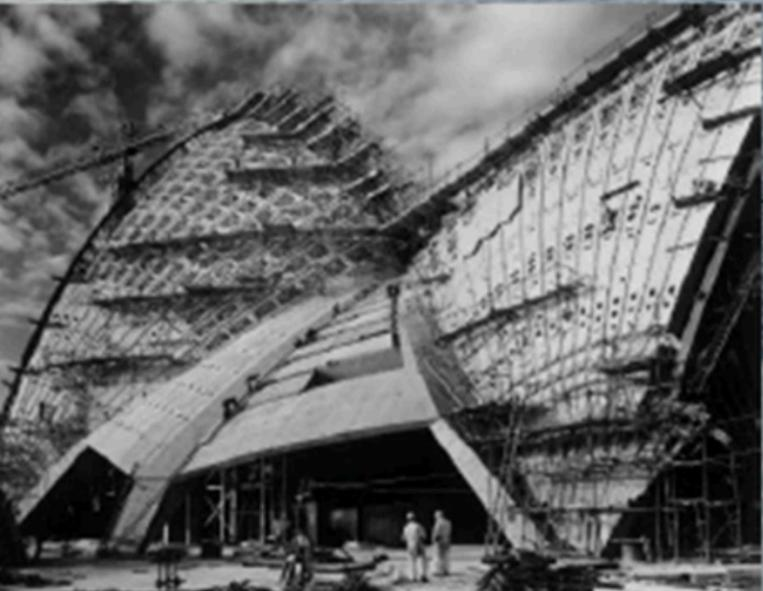
Los velas de la Ópera de Sydney, instaladas en 1963, son ejemplo de protección sin mantenimiento durante más de 50 años gracias al galvanizado de la malla de refuerzo y los cables de tensado.
