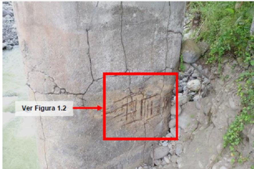
Figura 1.1. Acero de refuerzo expuesto con corrosión severa y desgaste de la sección de concreto en pila 1, cara oeste.
