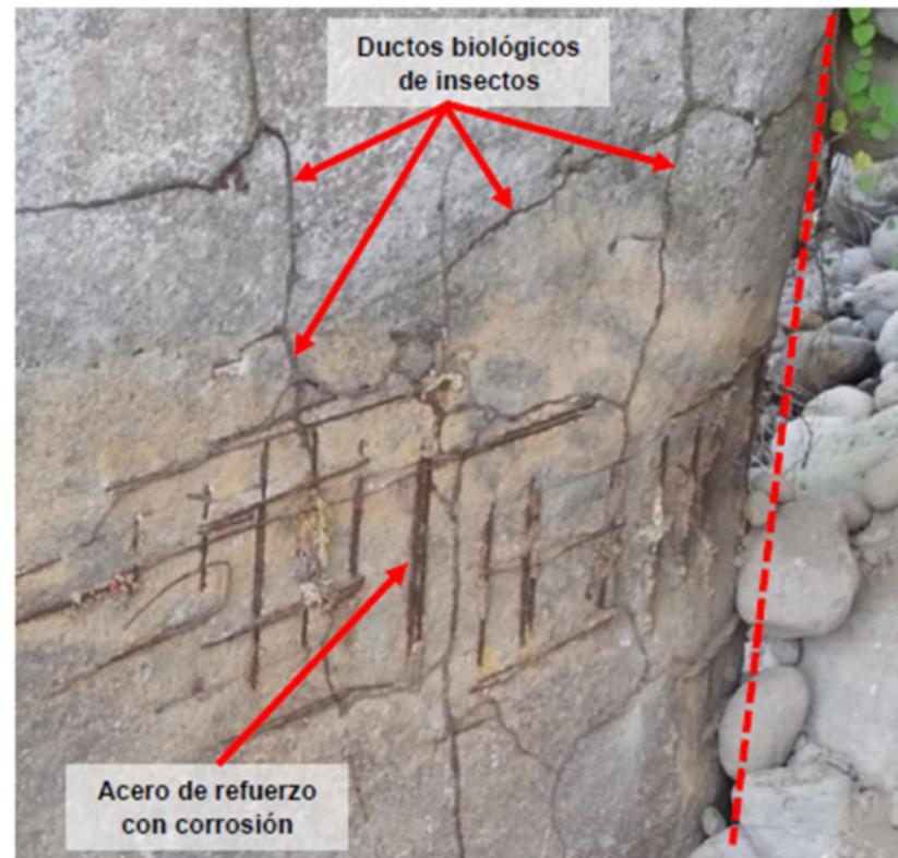
Figura 1.2. Acero de refuerzo expuesto con corrosión severa y desgaste de la sección de concreto en pila 1, cara oeste (acercamiento al recuadro de la Figura 1.1).
